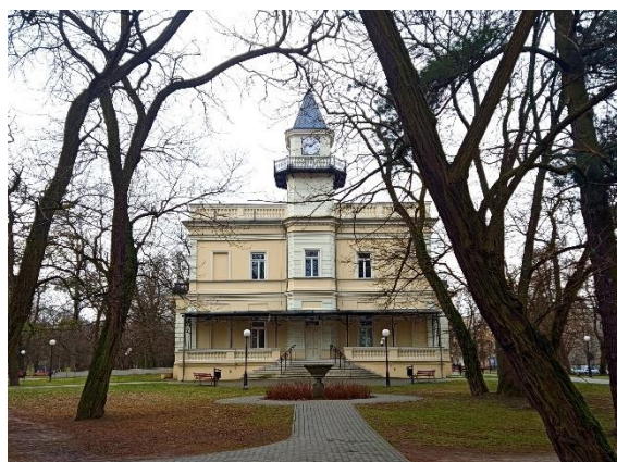
Zdjęcie 4. Pałac "Sokoła"
