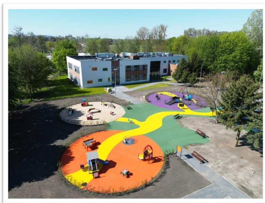
Zdjęcie z realizacji inwestycji „Budowa budynku Przedszkola Miejskiego nr 8 przy ul. 3-go Maja”
