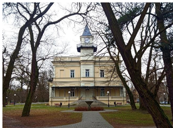
Zdjęcie 3. Pałac "Sokoła"
