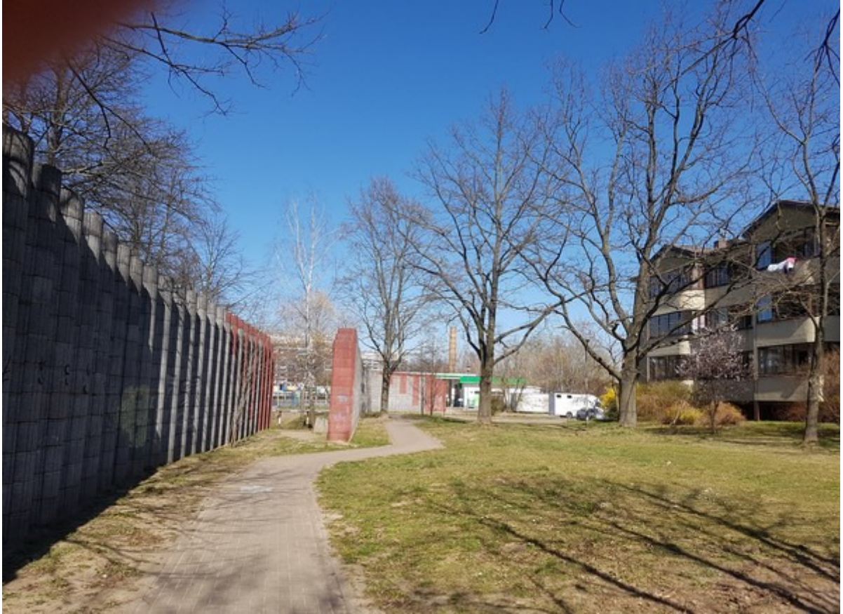
Fot. 3: Szpaler dębów szypułkowych za ekranami z gazonów betonowych.
