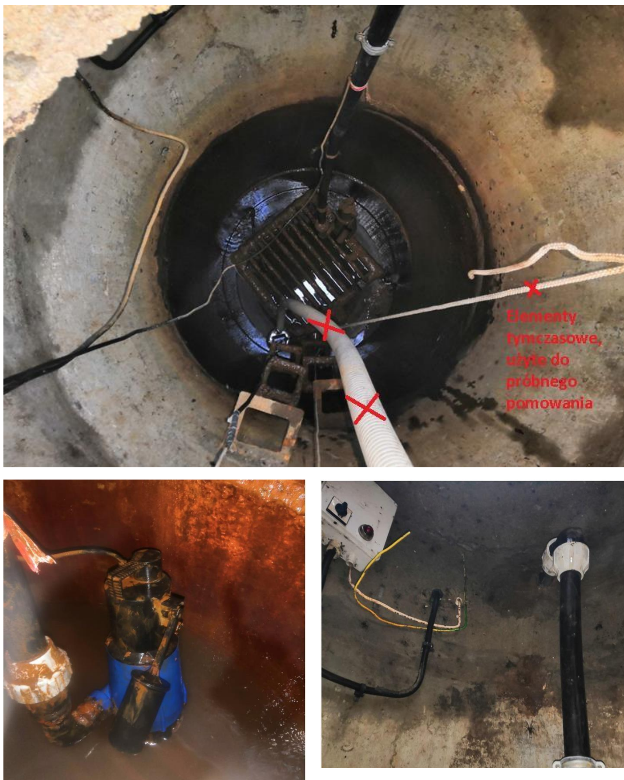
Fot. 5.6 Zdjęcia urządzeń umieszczonych w studni ujmującej wodę z dna rzeki Utraty używanej dla zasilania stawów
