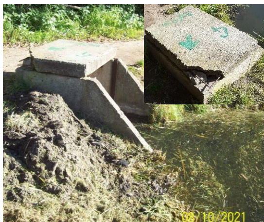
Fot. 4.7 Wlot (a) i wylot (b) przepustozastawki 2MN – uszkodzona płyta przykrywająca
