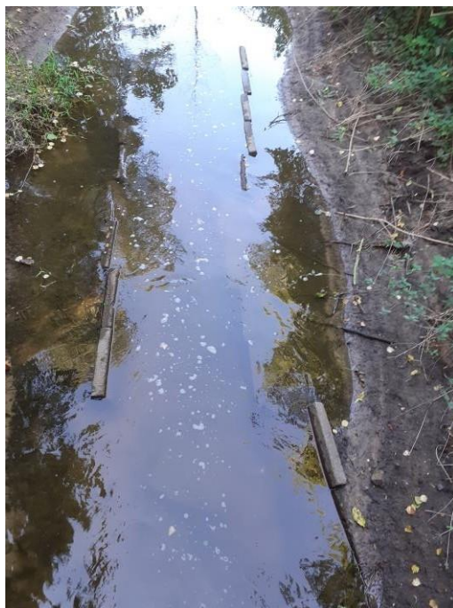
Fot. 4.12 Zniszczone umocnienia koryta za wylotem mnicha 6MN do Utraty
