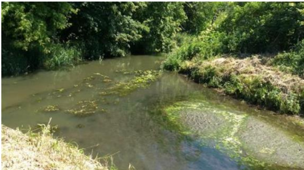
Fot. 6.1. Tworzące się odsypisko rumowiska na wlocie do doprowadzalnika A
