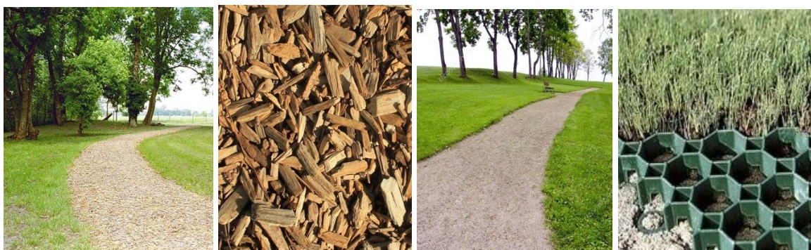
Zdjęcie nr 1, 2, 3, 4: Rodzaje projektowanych nawierzchni w ramach inwestycji: wodoprzepuszczalne, z materiałów naturalnych lub obsiane trawą: nawierzchnia ze zrębków drewnianych, nawierzchnia żwirowa, nawierzchnia z kratki trawnikowej.
