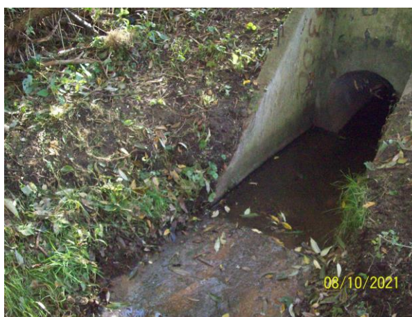
Fot. 4.7 Wlot (a) i wylot (b) przepustozastawki 2MN – uszkodzona płyta przykrywająca
