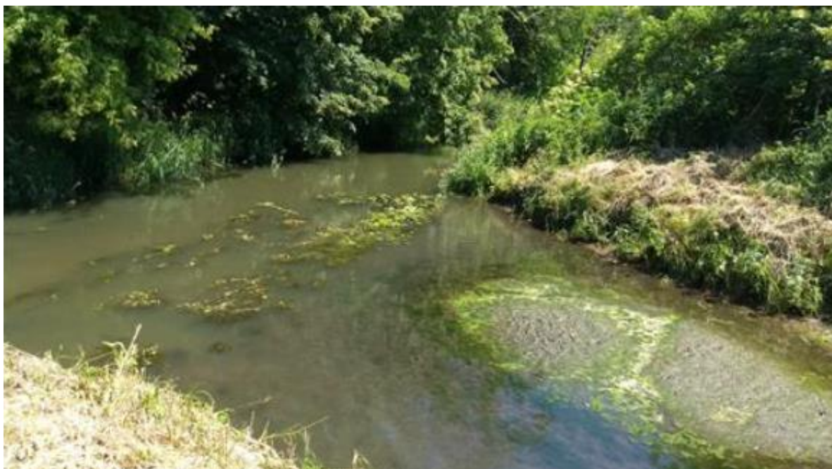
Fot. 6.1. Tworzące się odsypisko rumowiska na wlocie do doprowadzalnika A
