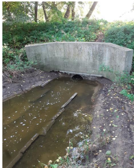
Rys. 4.20 Wylot mnicha 6MN: widok od strony kanału odprowadzającego (a) i widok z góry (b)
