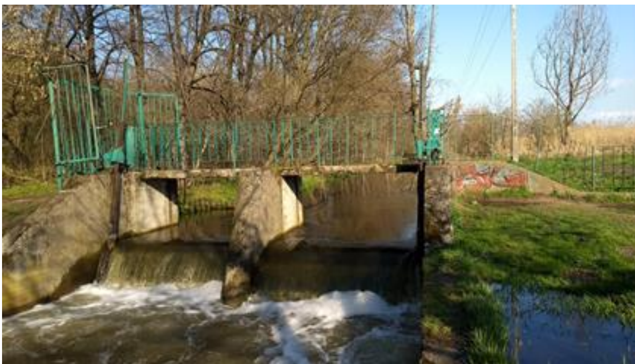
Fot. 4.1 Widok jazu od strony dolnego stanowiska – z prawej strony woda na powierzchni terenu wzdłuż ściany lewego przyczółka.
