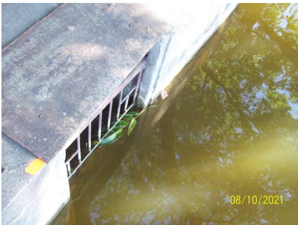
Fot. 4.11 Wlot (a) i wylot (b) mnicha spustowego 6MN
