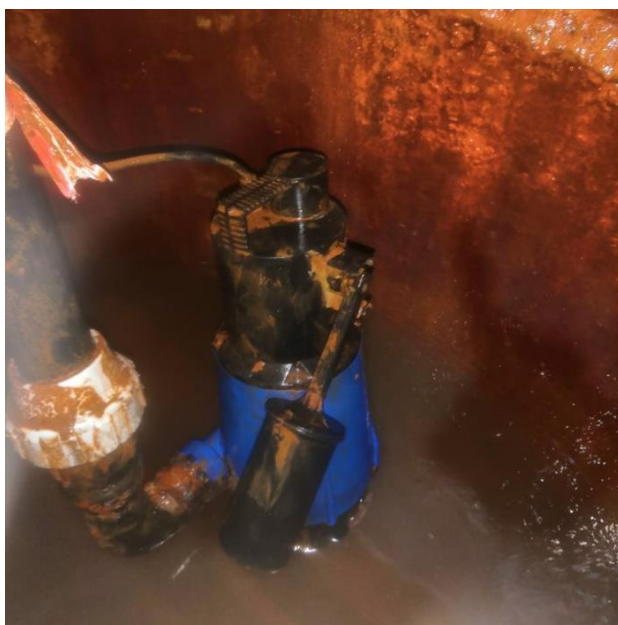
Fot. 5.6 Zdjęcia urządzeń umieszczonych w studni ujmującej wodę z dna rzeki Utraty używanej dla zasilania stawów
