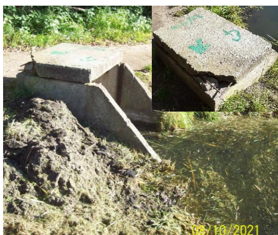
Fot. 4.7 Wlot (a) i wylot (b) przepustozastawki 2MN – uszkodzona płyta przykrywająca
