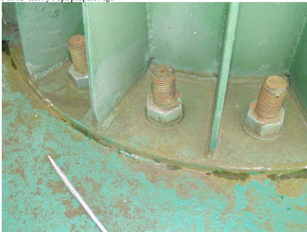
Fot.4.3 Kotwy słupa podporowego
