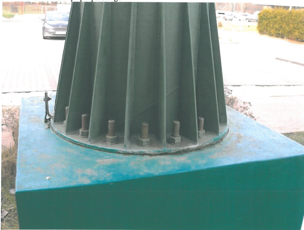
Fot.4.3 Kotwy słupa podporowego
