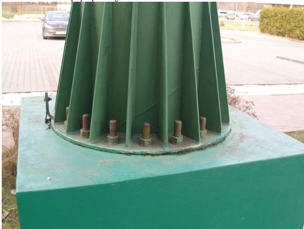
Fot.4.3 Kotwy słupa podporowego
