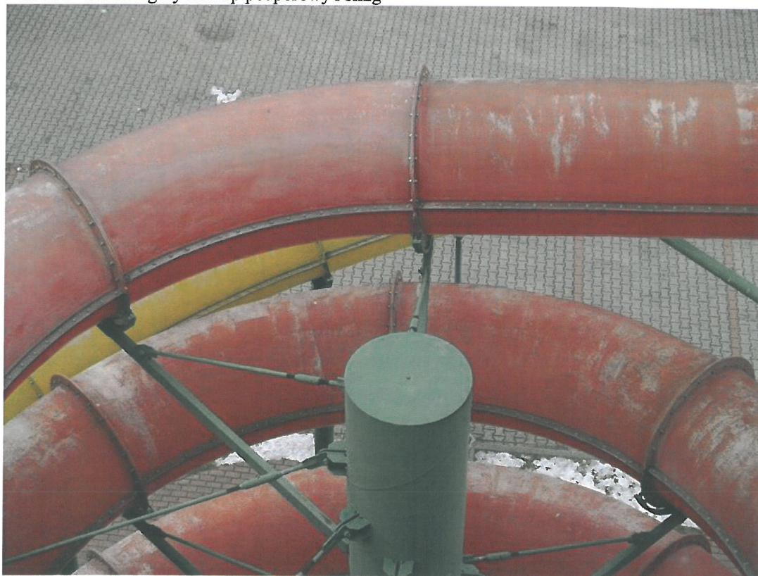
Fot.4.10 Widok z góry na słup podporowy i ślizg
