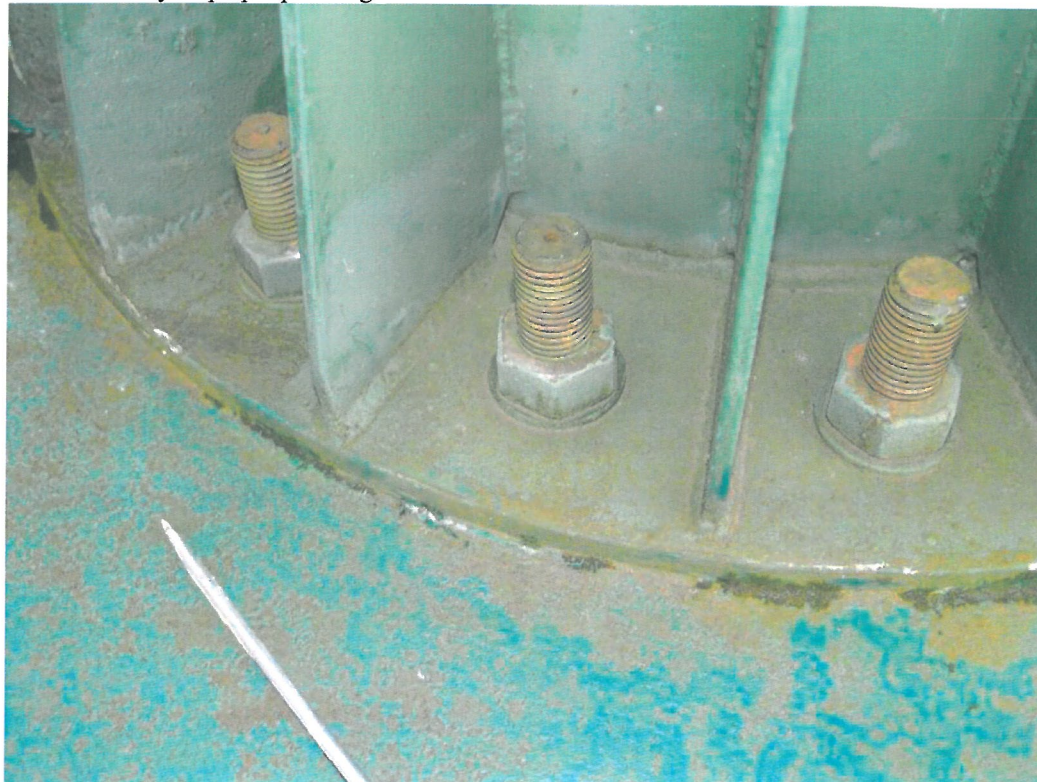
Fot.4.3 Kotwy słupa podporowego
